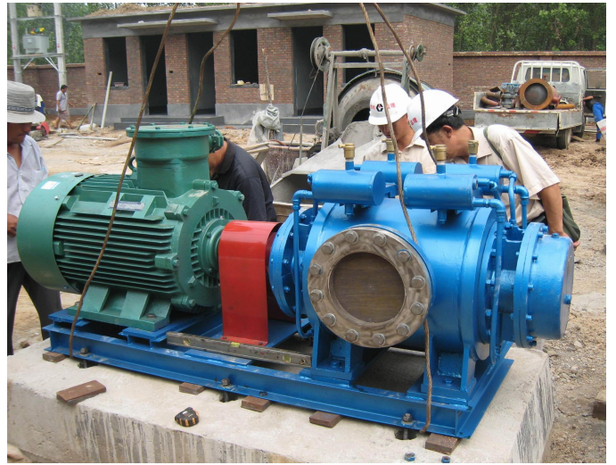
双螺杆泵安装现场
