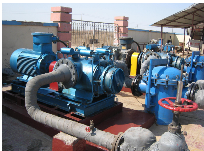
我公司生产的双螺杆泵在油田使用现场
